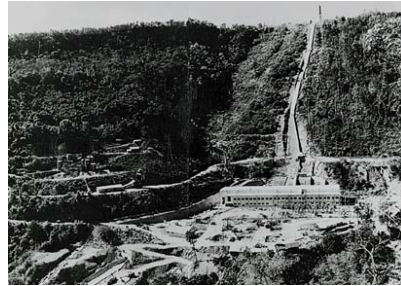
バルーチャウン第二水力発電所改修事業
